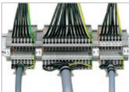
Установка кабеля в распределительную коробку. Кабель устанавливается с подключенными розетками и вставляется прямо в базовые клеммы.
