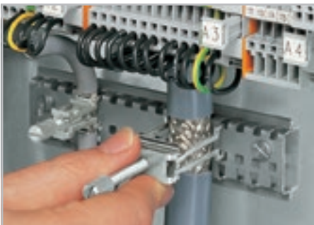
Установка дополнительного зажима для экрана.
