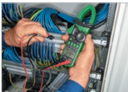
Проверка наличия напряжения в распределительном шкафу
